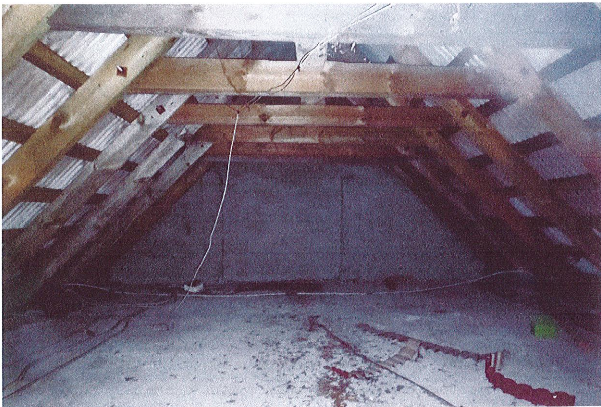
Fot. 15 Więźba dachowa nad prezbiterium
