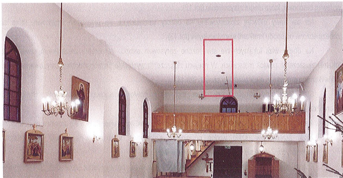
Fot. 13 Kratki wentylacyjne w stropie na przestrzeń strychu
