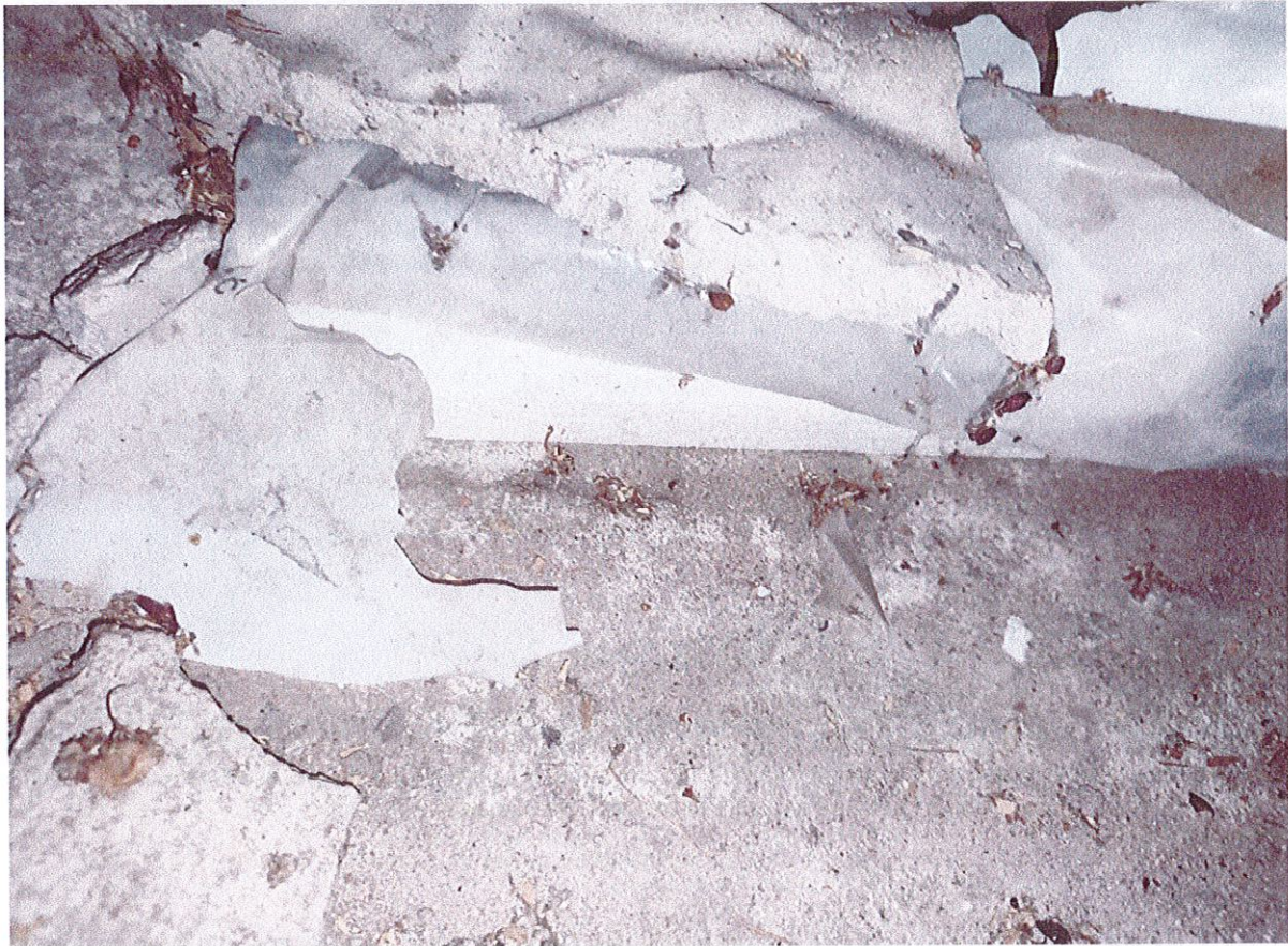
Fot. 12 Ocieplenie stropu styropianem, folia oraz cienka wylewka
