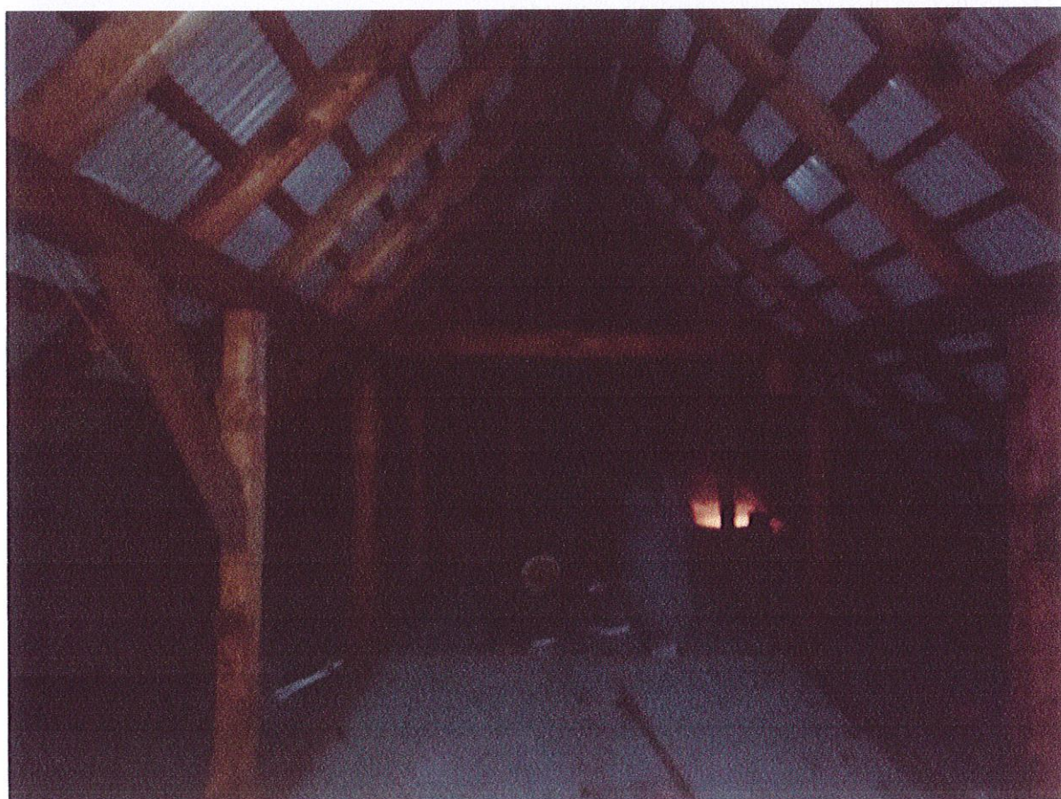
Fot. 16 Więźba dachowa nad nawą
