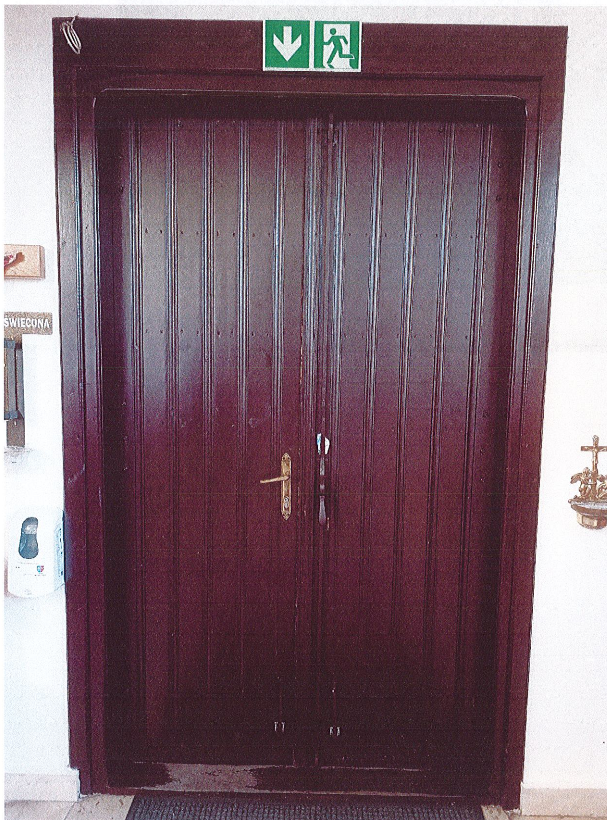
Fot. 20 Widok drzwi głównych do kościoła od wewnątrz
