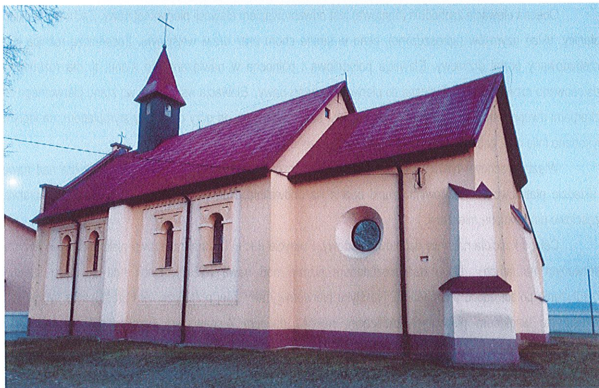
Fot. 5 Kościół w Januszewicach – elewacja południowa i wschodnia (2024)
